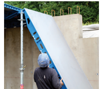
Optimales Handling durch ergonomische Grifflöcher im Randprofil
