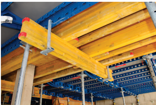
Schnelles Schließen von Ausgleichsbereichen mit Einhängbügel und Träger, ohne zusätzliche Deckenstützen
